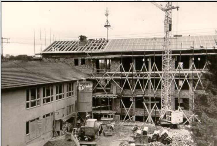
1962: Roh-Bau von Trakt II
