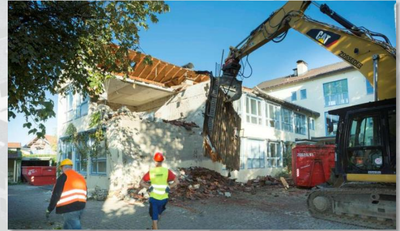
2018: Abriss von altem Trakt I
