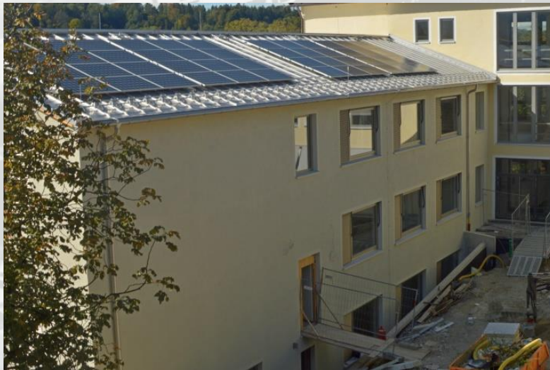
2019: der neue Trakt I in der Fertigstellungsphase
